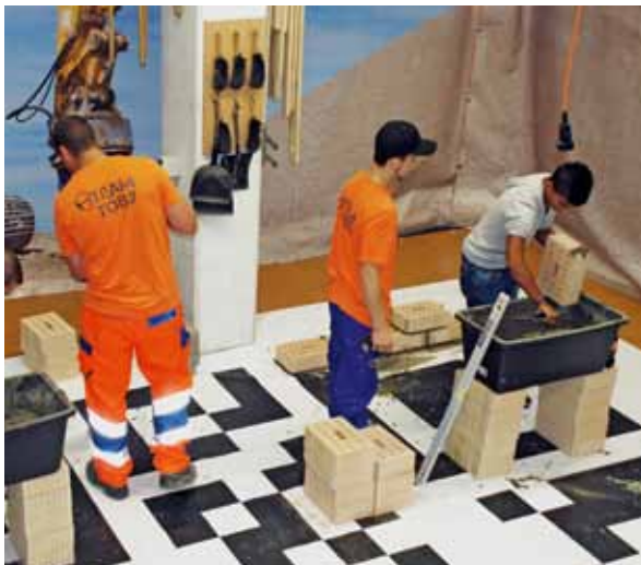
Hier wird der grösste dreidimensionale QR-Code der Schweiz gebaut.
